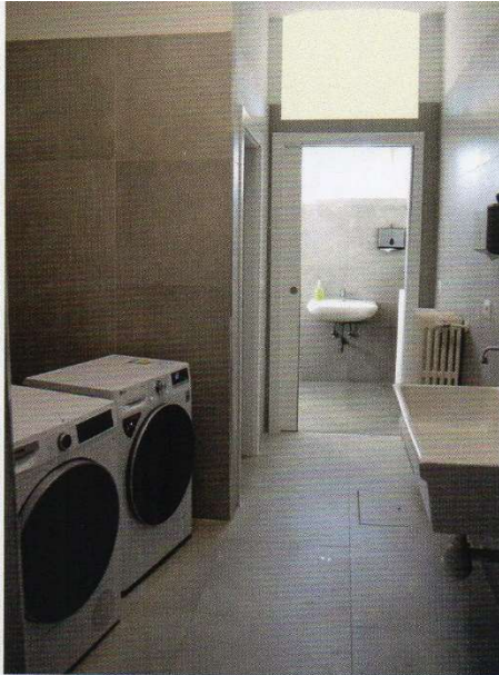
Antibagno, prima e dopo l'intervento di ristrutturazione
